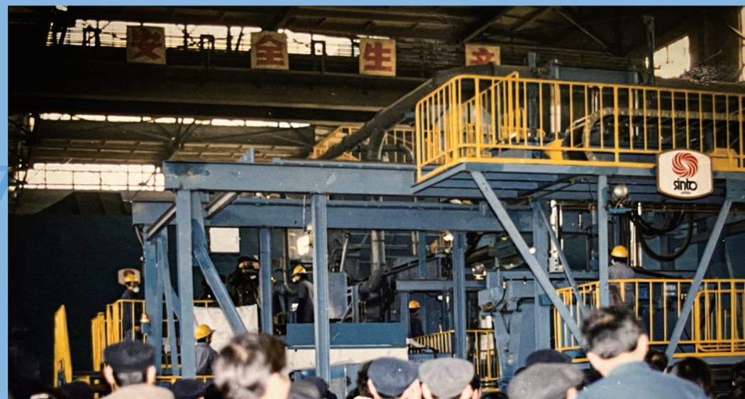
由公司为北京化工设备厂引进的真空造型设备
